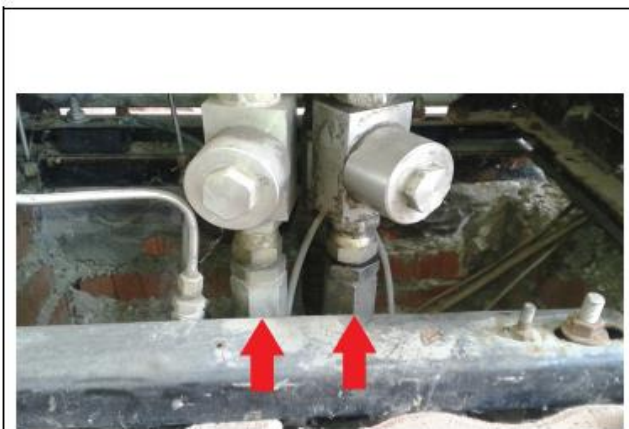
Foto 3: Base dell'erogatore con indicazione delle valvole a eccesso di flusso
